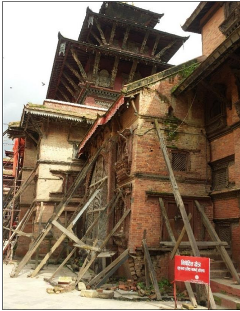
(d) Example of shoring using timber members
