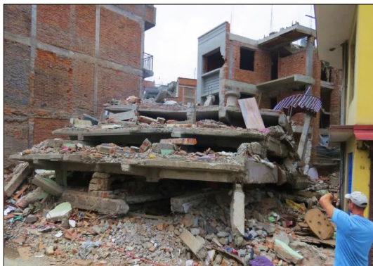
(d) Pancake collapse
