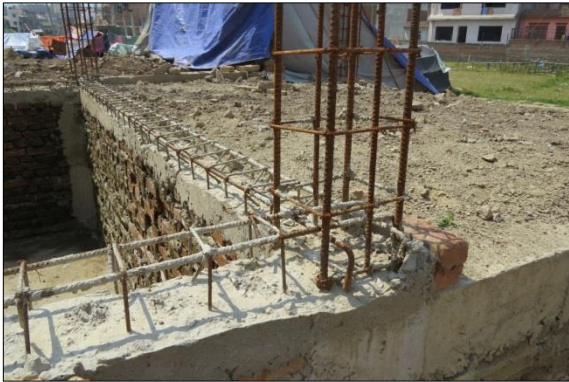
(d) Construction of the reinforced concrete stringcourse
