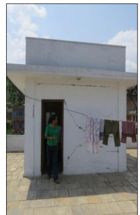
(d) Shear wall type of support platform
