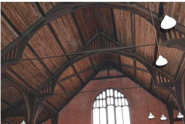
(d) All Saints (1913), Palmerston North - Rafters roof
