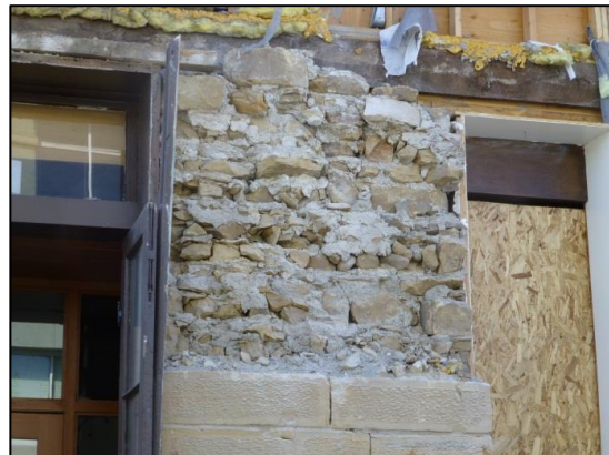
(d) Close up of rubble fill
