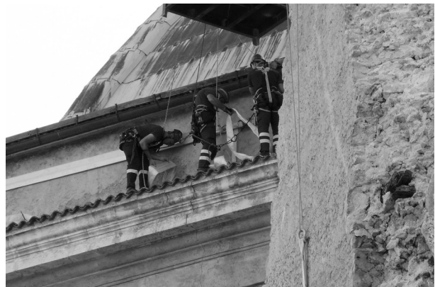
Figure 22: Firemen securing the Dome of "Chiesa di San Bernardino" (L'Aquila).
