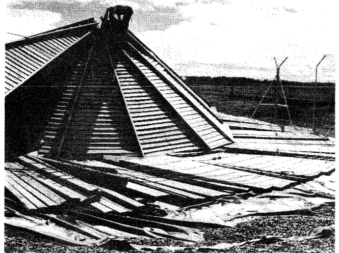
Fig. 4.3.1 : Edgcombe timber tank
