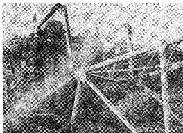
(d) Detail of South Span Collapse.
